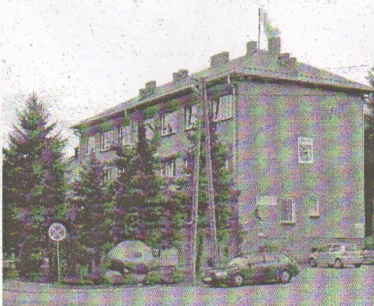
Nowy dach budynku Urzędu Gminy
